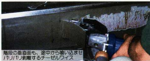
固着した防水剤剥離中(2台で作業)
